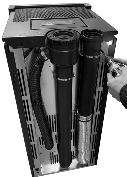
Fig. 49 - Fixer le tuyau d.80 mm
