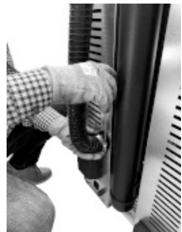
Fig. 37 - Raccorder le tuyau de l'air comburant
