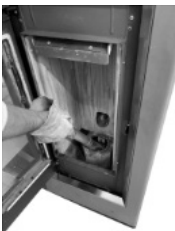
Fig. 32 - Nettoyage l'espace du brasero
