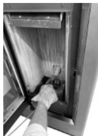
Fig. 33 - Nettoyage avec nettoie-pipes
