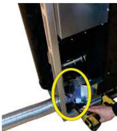
Fig. 37 - Bloccare tubo flessibile
