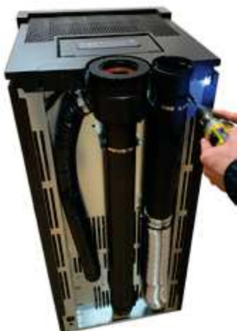
Fig. 40 - Bloccare tubo d.80 mm
