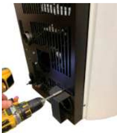
Fig. 34 - Rimozione deviatore
