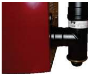
Fig. 54 - Pulizia canale da fumo
