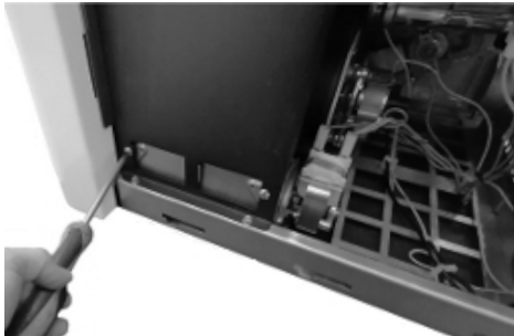
Fig. 66 - Pulizia ventilatore ambiente
