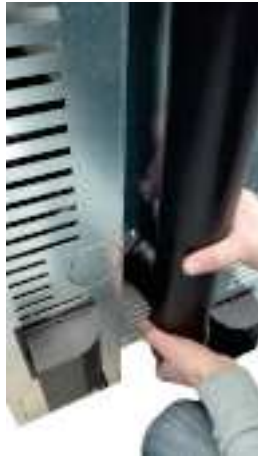
Fig. 27 - Innestare tubo d.80 mm
