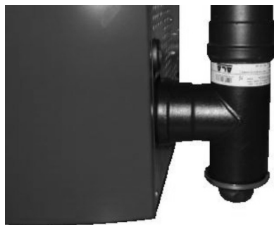
Fig. 54 - Pulizia canale da fumo
