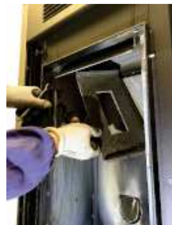
Fig. 57 - Rimuovere la testa del focolare 2
