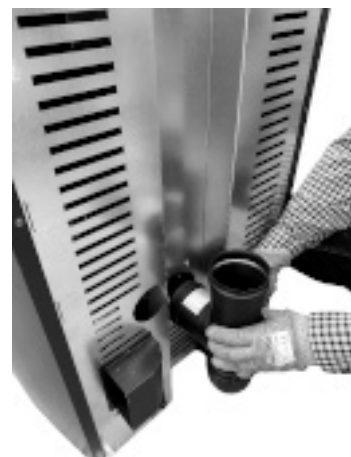
Fig. 22 - Collegare raccordo a T
