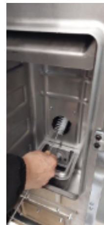
Fig. 42 - Limpieza con escobilla
