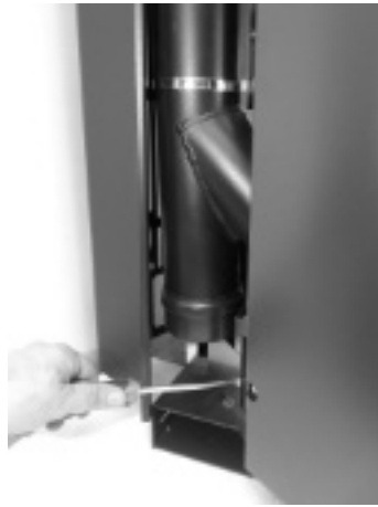
Fig. 71 - Schroef de dopblokkering los
