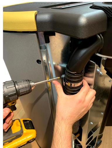
Fig. 64 - Retirar el tubo flexible
