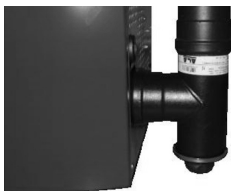
Fig. 71 - Limpieza canal de humos
