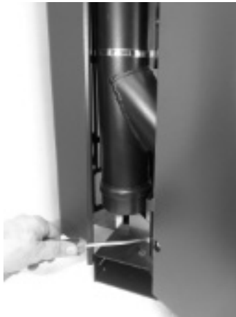
Fig. 73 - Desatornille el tope de la tapa
