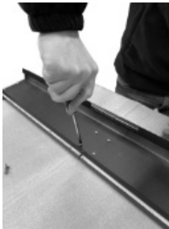
Fig. 45 - Montaje de las mayólicas
