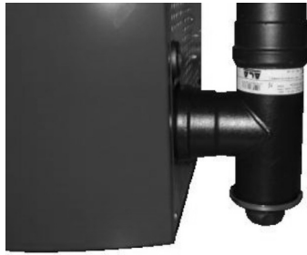
Fig. 69 - Reinigung des Rauchgaskanals
