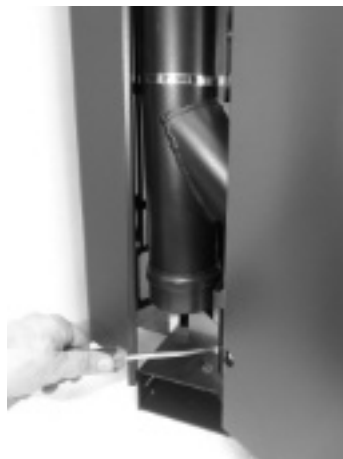
Fig. 71 - Den Deckelhalter lösen
