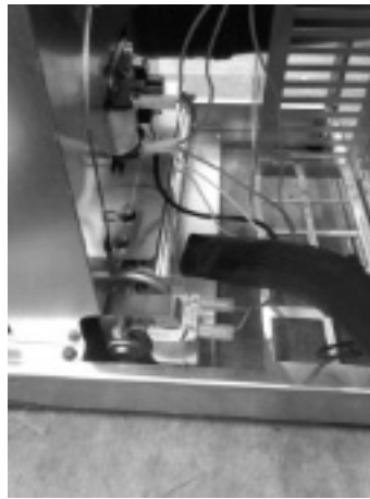
Fig. 81 - Room fan cleaning
