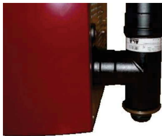
Fig. 73 - Fume conduit cleaning
