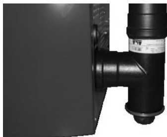
Fig. 78 - Nettoyage du conduit de fumée
