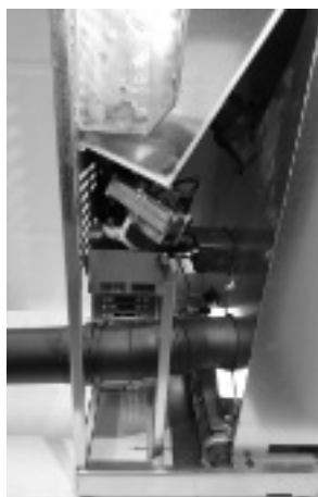
Fig. 62 - Sortie de fumées postérieure Sharp
