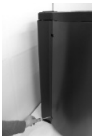
Fig. 79 - Dévisser les vis latérales
