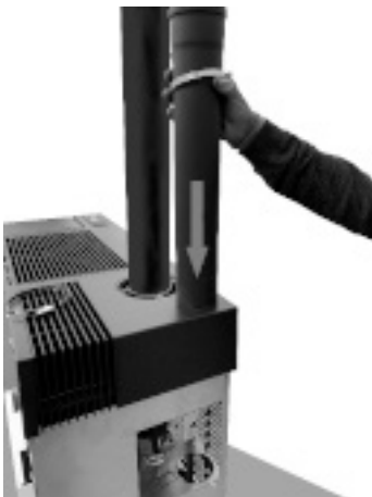
Fig. 102 - Plaats de kanaliseringbuis
