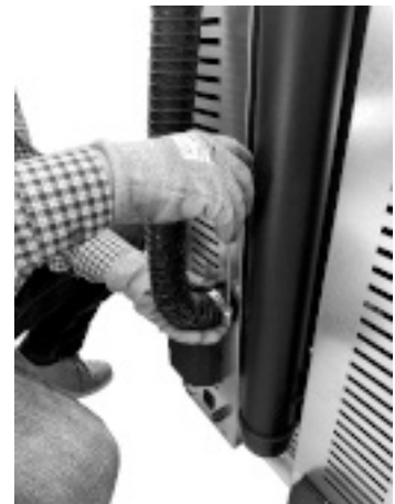
Fig. 75 - Koppel de buis van de verbrandingslucht
