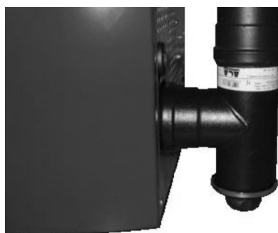
Fig. 116 - Reiniging rookleiding
