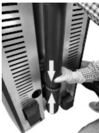
Fig. 71 - Sluit de buizen aan
