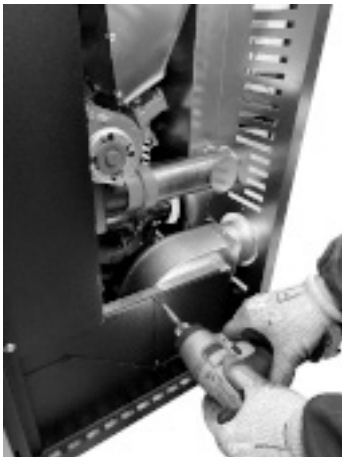
Fig. 80 - Positionering van de buizen voor kanalisering
