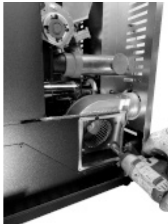
Fig. 81 - Bevestiging van de buis
