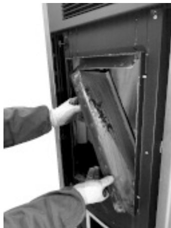
Fig. 121 - Verwijder de zijwanden
