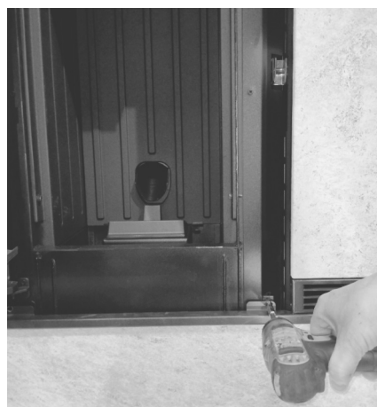
Fig. 64 - Vastschroeven op de lipjes
