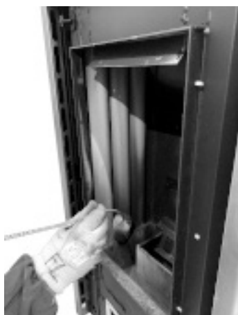
Fig. 123 - Reinig met pijpenwisser
