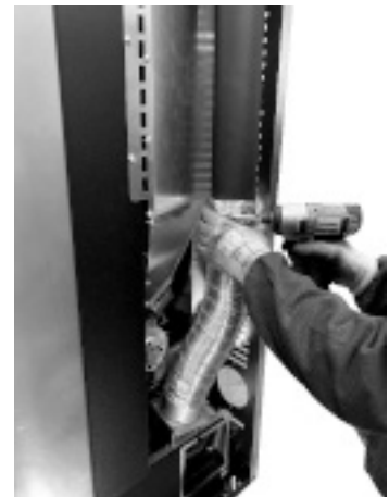
Fig. 85 - Bevestig de buizen
