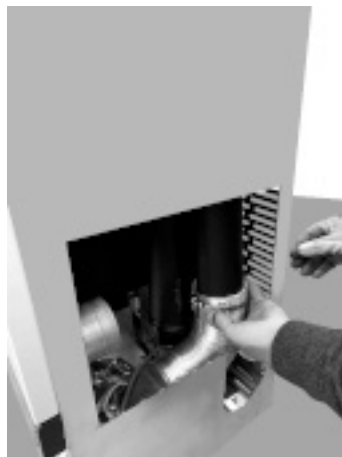
Fig. 103 - Sluit de buizen aan
