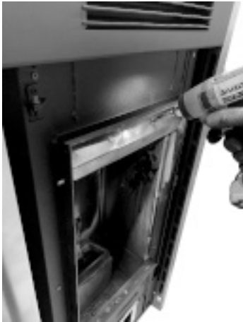
Fig. 117 - Verwijder de deflector
