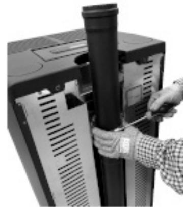
Fig. 74 - Descarga de humos posterior montada
