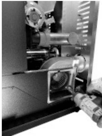
**Fig. 83 - Extraiga los tornillos del ventilador**
