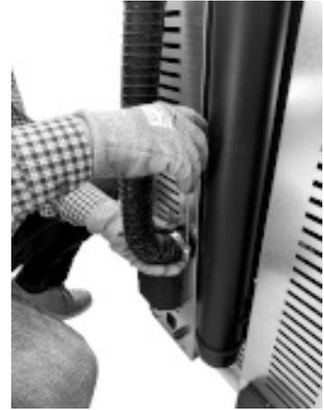
*Fig. 77 - Acople el tubo de aire comburente*
