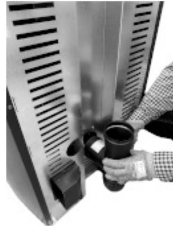
Fig. 71 - Conecte el racor en T
