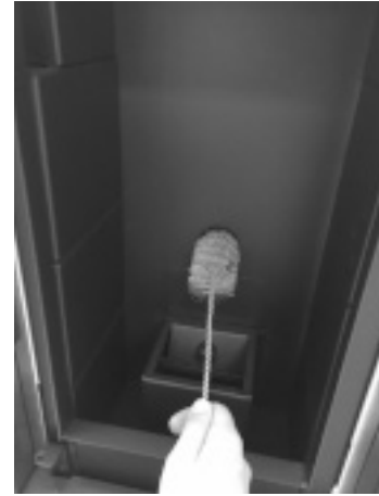
Fig. 36 - Limpieza con escobilla
