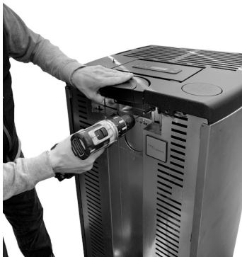
Fig. 68 - Stopfen entfernen
