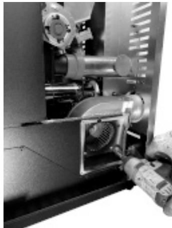
Fig. 81 - Die Ventilatorschrauben entfernen
