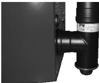
Fig. 116 - Reinigung des Rauchgaskanals
