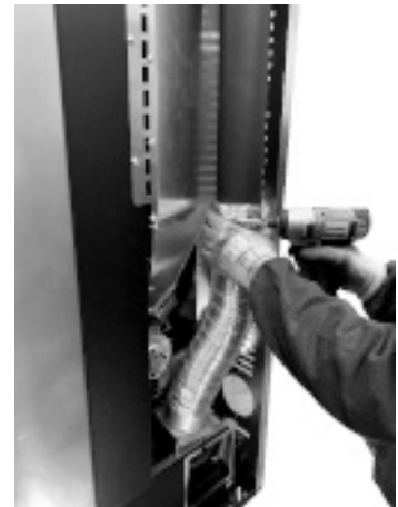
Fig. 85 - Die Rohre befestigen
