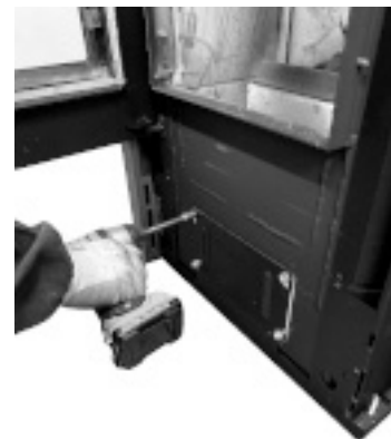
Fig. 113 - Stopfen entfernen
