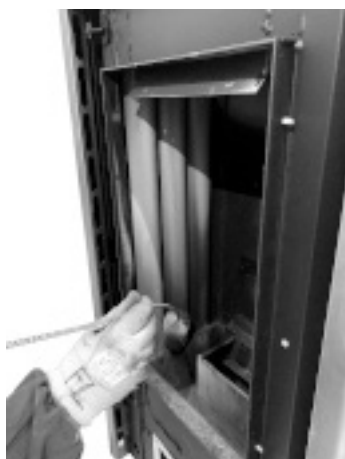
Fig. 123 - Mit einer Rohrreinigungsbürste reinigen
