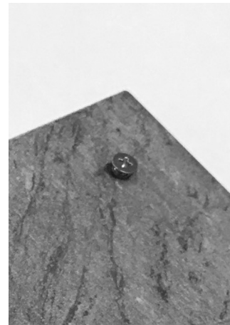
Fig. 59 - Die Schraube muss vorstehen
