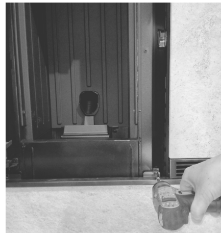
Fig. 64 - An den Laschen festschrauben
