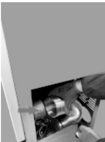
Fig. 99 - Das Kanalisationsrohr einführen
