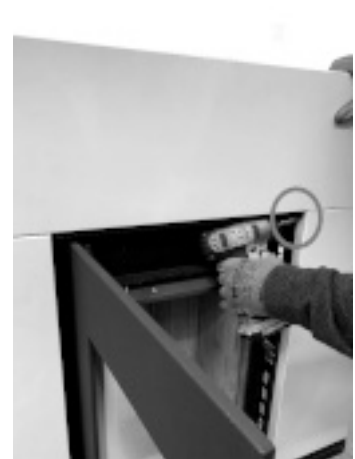
Fig. 44 - Die obere Platte befestigen
