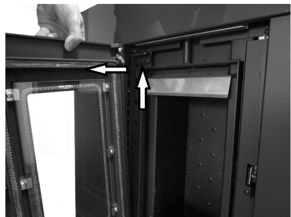
Fig. 20 - Ausbau der Tür
