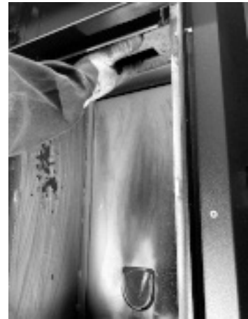
Fig. 119 - Die Stirnseite des Feuerraums 1 entfernen
