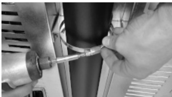
Fig. 76 - Mit Schellen fixieren
