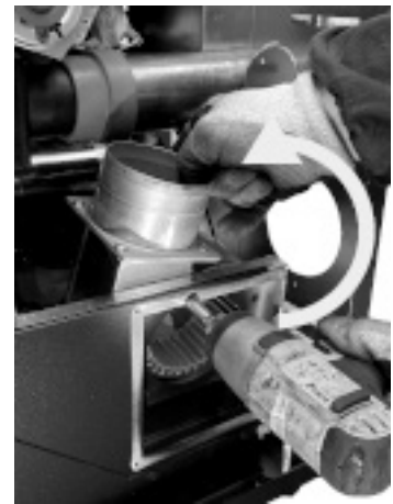
Fig. 82 - Remove fan
