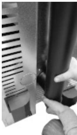
Fig. 74 - Insert pipe d.80 mm
