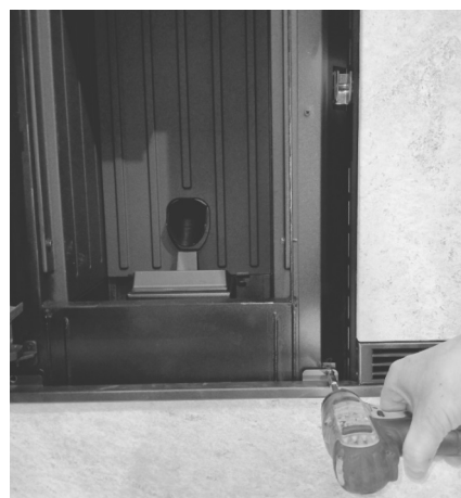
Fig. 73 - Visser sur les ailettes
