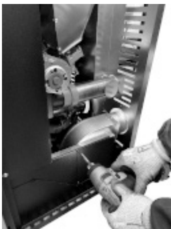
Fig. 89 - Positionnement des tuyaux pour la canalisation
