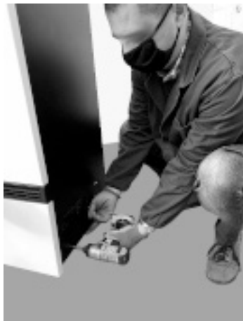
Fig. 74 - Retrait des vis
