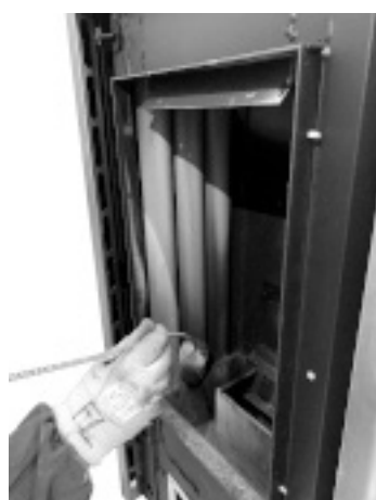
Fig. 131 - Nettoyer avec un goupillon
