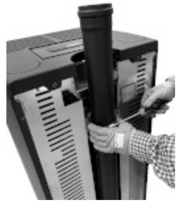
Fig. 81 - Conduit arrière d'évacuation des fumées monté
