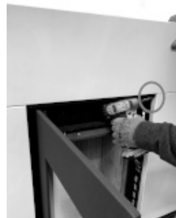
Fig. 53 - Fixer le panneau supérieur
