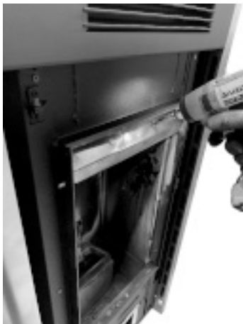
Fig. 125 - Retirer le déflecteur
