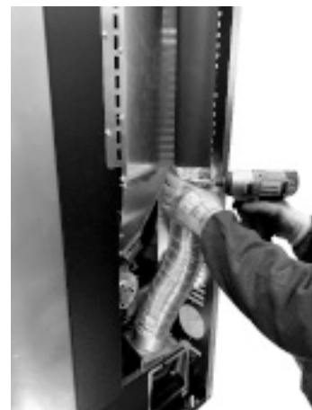
Fig. 93 - Fixer les tuyaux
