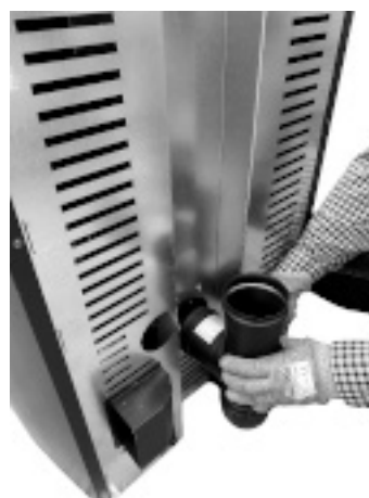
Fig. 78 - Raccorder le raccord en T.
