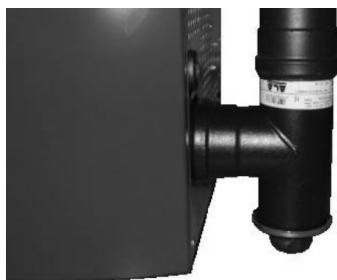
Fig. 124 - Nettoyage du conduit de fumée
