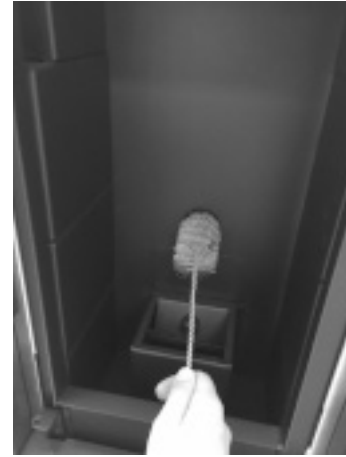
Fig. 36 - Nettoyage avec nettoie-pipes
