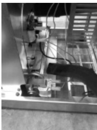
Fig. 77 - Pulizia ventilatore ambiente
