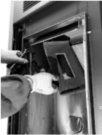
**Fig. 120 - Rimuovere la testa del focolare 2**
