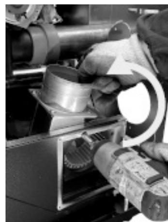
**Fig. 82 - Ruotare ventilatore**
