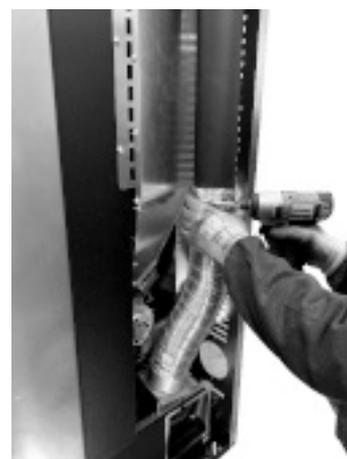
**Fig. 85 - Fissare i tubi**
