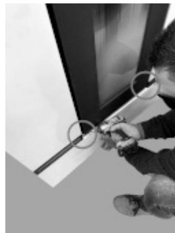
**Fig. 47 - Fissare pannello inferiore**
