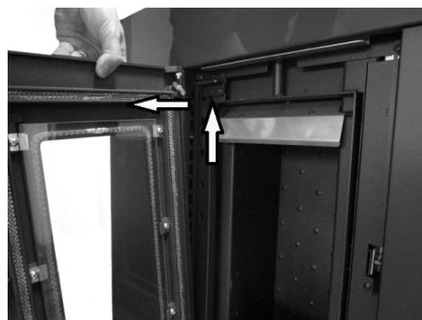
Fig. 20 - Rimozione porta
