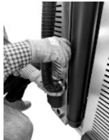
Fig. 75 - Innestare tubo dell'aria comburente
