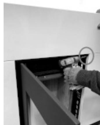
**Fig. 44 - Fissare pannello superiore**
