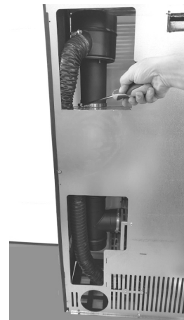
Fig. 47 - Vastzetten met buisklem
