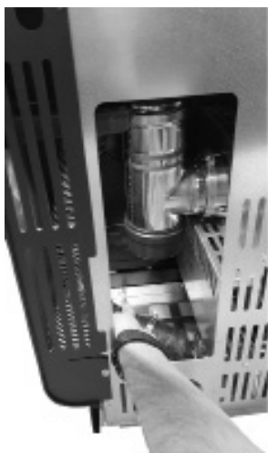
Fig. 48 - Flexibele buis invoegen
