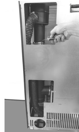
Fig. 49 - Bloqueo con abrazadera
