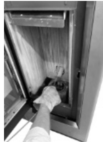
Fig. 34 - Limpieza con escobilla
