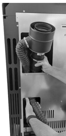
**Fig. 46 - Rohr Durchm. 80 mm einstecken**
