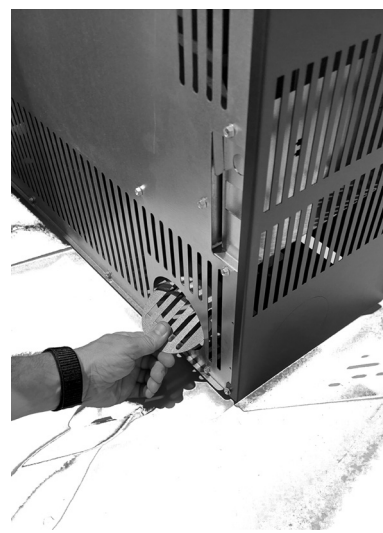
Fig. 48 - Passage du tuyau
