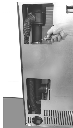
Fig. 55 - Bloquer avec un collier de serrage
