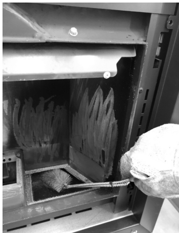
Fig. 26 - Reinig met pijpenwisser
