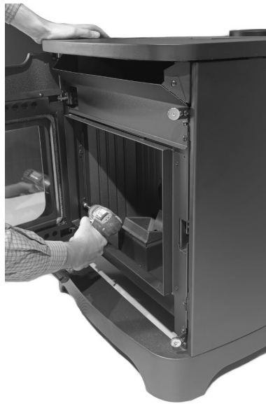
Fig. 31 - Retire los hierros fundidos laterales
