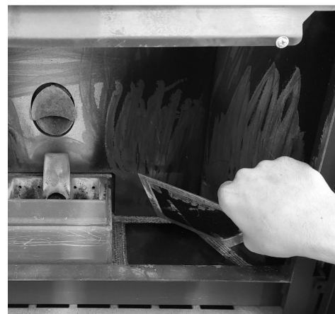
Fig. 25 - Den Inspektionsstopfen entfernen
