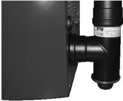
Fig. 22 - Reinigung des Rauchgaskanals
