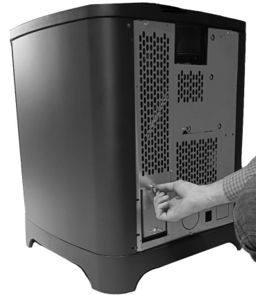
Fig. 23 - Reinigung des Rauchgaskanals
