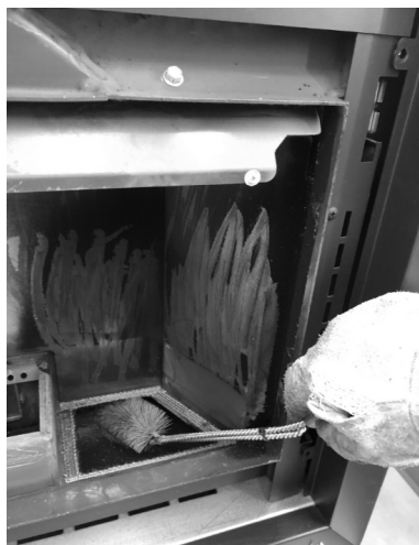
Fig. 35 - Nettoyer avec un goupillon.
