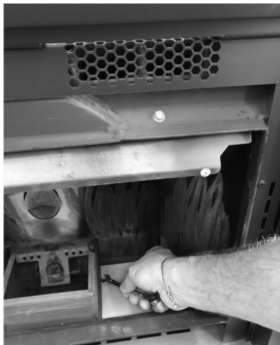
Fig. 33 - Retirer les vis
