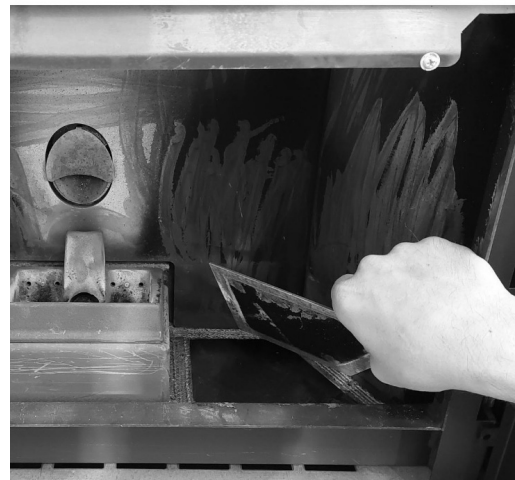
Fig. 34 - Retirer le bouchon d'inspection
