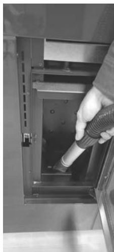
Fig. 35 - Rengøring af fyrfadsrum
