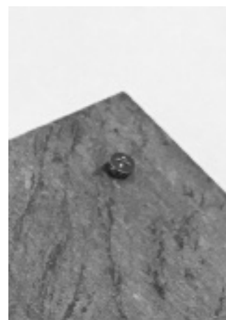
Fig. 31 - El tornillo debe sobresalir
