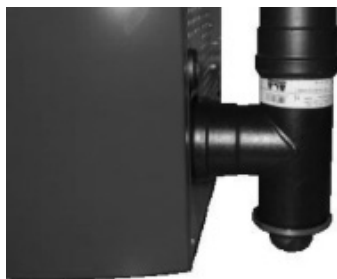
Fig. 68 - Limpieza canal de humos
