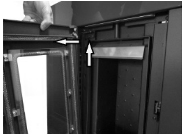
Fig. 21 - Desmontaje de la puerta
