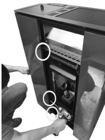
Fig. 47 - Extracción de los tornillos 3
