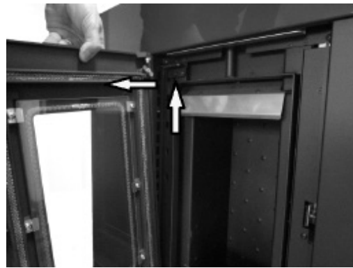
Fig. 19 - Ausbau der Tür
