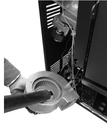
Fig. 74 - Reinigung des Raumventilators
