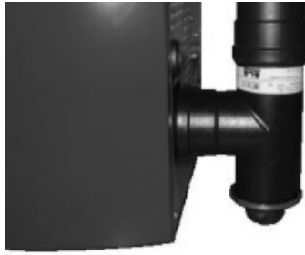
Fig. 66 - Reinigung des Rauchgaskanals
