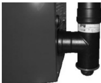
Fig. 66 - Fume conduit cleaning
