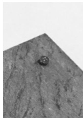
Fig. 38 - La vis doit dépasser
