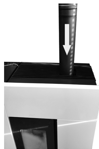
Fig. 52 - Inserire tubo
