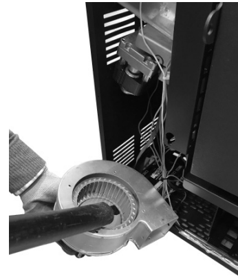
Fig. 74 - Pulizia ventilatore ambiente
