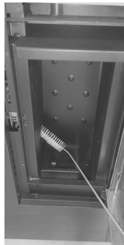
Fig. 36 - Limpieza con escobilla
