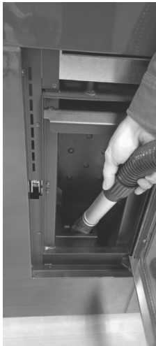
Fig. 35 - Reiniging ruimte vuurpot
