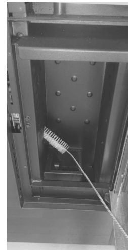
Fig. 36 - Reiniging met flessenwisser
