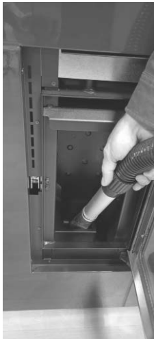
Fig. 35 - Nettoyage l'espace du brasero
