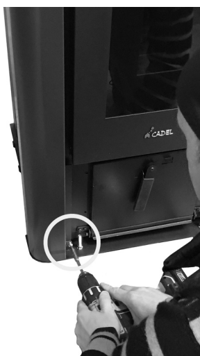
Fig. 26 - Fijación del marco
