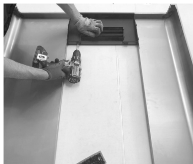
Fig. 41 - Fijación de la rejilla
