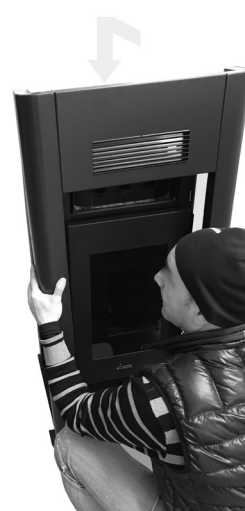
Fig. 25 - Posicionamiento del marco
