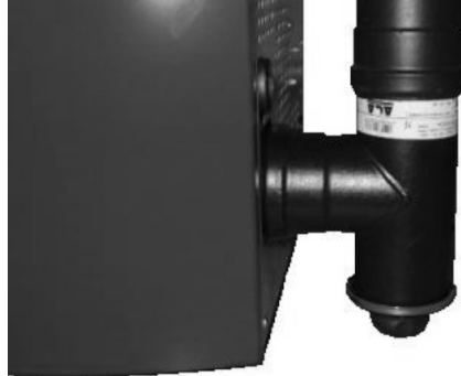
Fig. 78 - Limpieza canal de humos
