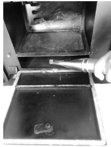
Fig. 87 - Aspire las cenizas
