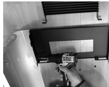
Fig. 31 - Fije el panel al montante
