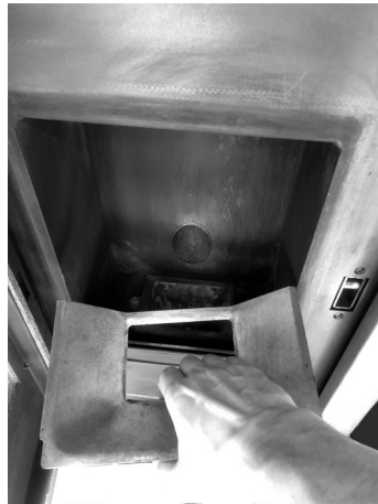
Fig. 84 - Aspire las cenizas
