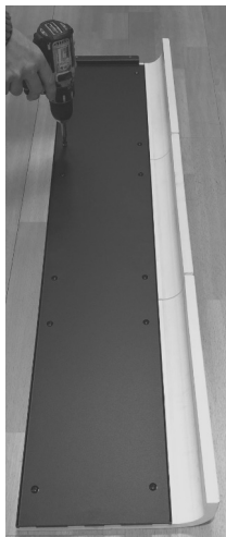
Fig. 36 - Montaje de las mayólicas
