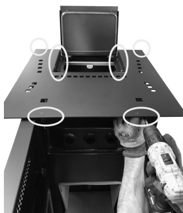
Fig. 49 - Extracción de los tornillos
