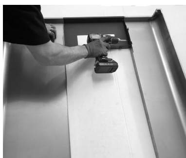
Fig. 40 - Fijación del montante
