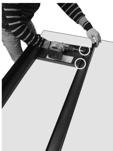
Fig. 23 - Fijación del montante
