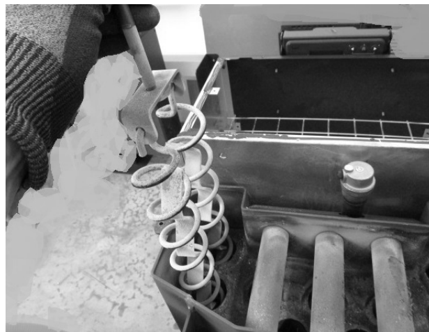
Fig. 96 - Sustitución de los turbuladores si es necesario
