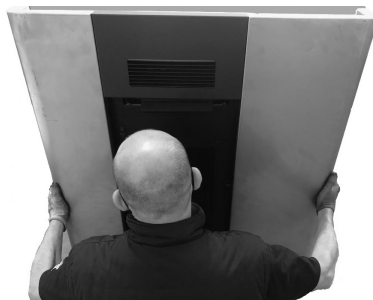
Fig. 44 - Posicionamiento del marco
