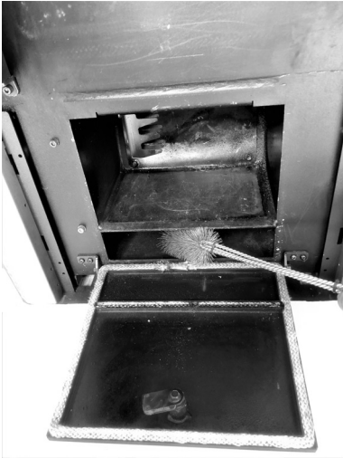
Fig. 81 - Mit einer Rohrreinigungsbürste reinigen
