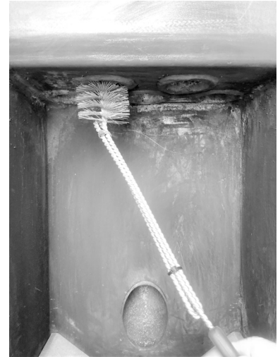
Fig. 83 - Mit einer Rohrreinigungsbürste reinigen
