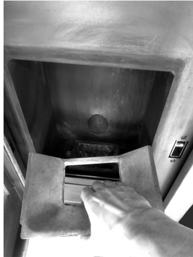
Fig. 82 - Die Asche absaugen
