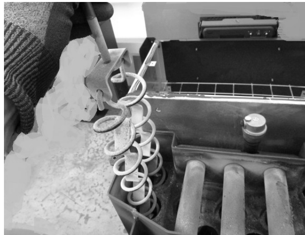
Fig. 94 - Austausch der Turbulatoren, wenn erforderlich
