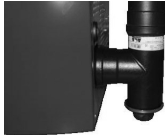
Fig. 76 - Reinigung des Rauchgaskanals
