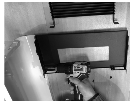
Fig. 29 - Die Platte an der Strebe befestigen
