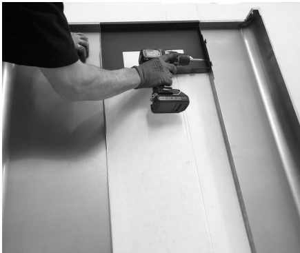
Fig. 38 - Befestigung des Trägers
