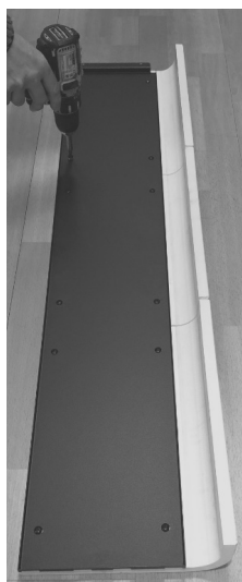
Fig. 34 - Verlegen der Majoliken
