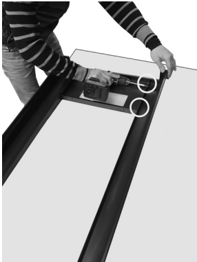
Fig. 21 - Befestigung des Trägers
