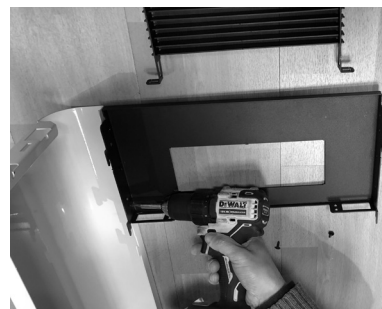
Fig. 29 - Fissare il pannello al montante
