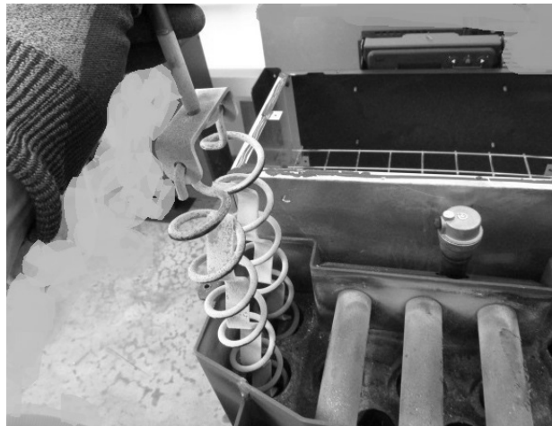
Fig. 95 - Sostituzione turbolatori se necessario
