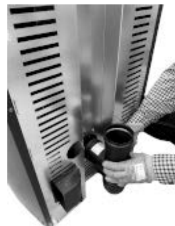
Fig. 69 - Sluit een T-aansluiting aan
