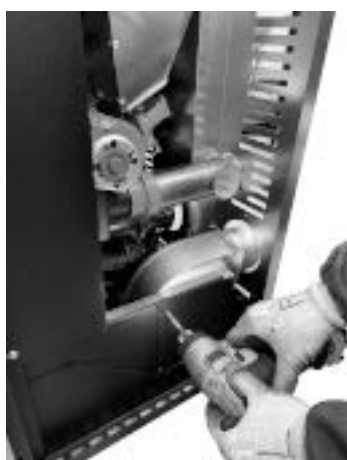
Fig. 80 - Positionering van de buizen voor kanalisering
