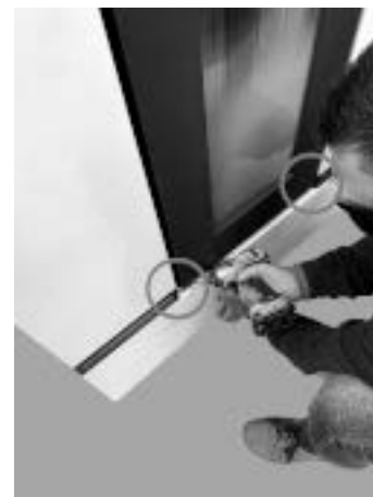
Fig. 47 - Bevestig onderste paneel
