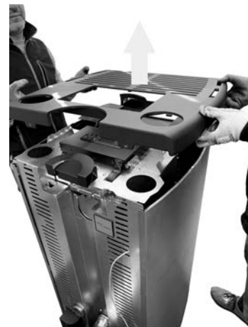
Fig. 22 - Verwijder het deksel
