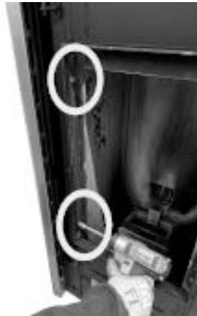
Fig. 117 - Verwijder de zesnantschroeven
