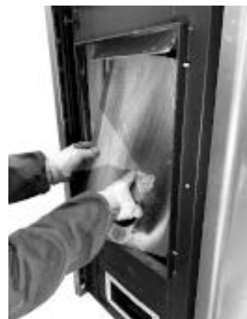
Fig. 121 - Verwijder het achterpaneel van de vuurhaard
