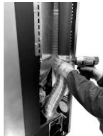
Fig. 84 - Bevestig de buizen
