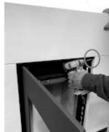
Fig. 44 - Bevestig bovenste paneel
