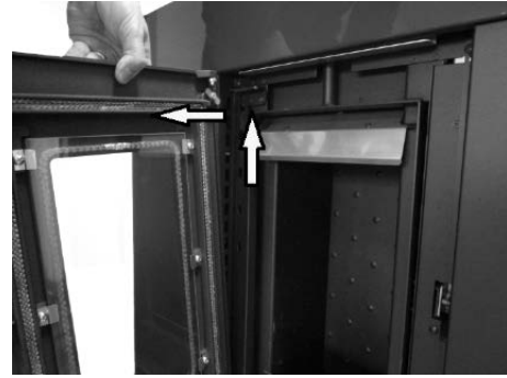
Fig. 20 - Verwijdering van de deur
