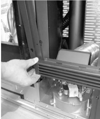
Fig. 54 - Luchtopening optillen
