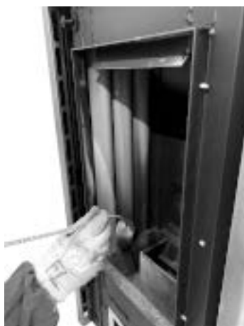
Fig. 122 - Reinig met pijpenwisser
