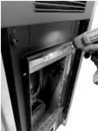
Fig. 116 - Verwijder de deflector
