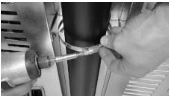
Fig. 76 - Blokkeer met klem
