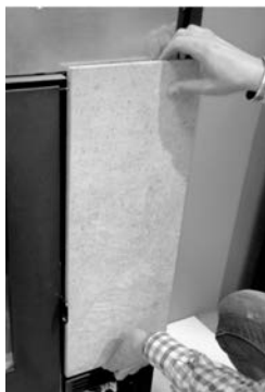
Fig. 60 - Koppel de steen vast
