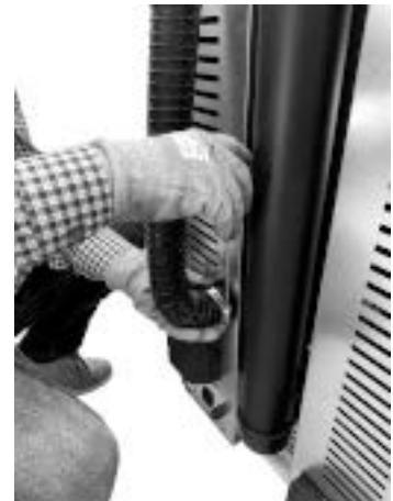
Fig. 75 - Koppel de buis van de verbrandingslucht
