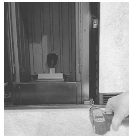
Fig. 64 - Vastschroeven op de lipjes
