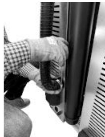
Fig. 73 - Acople el tubo de aire comburente
