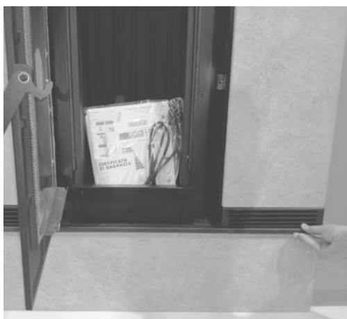
Fig. 60 - Colocar piedra y perfil
