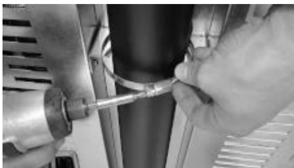
Fig. 74 - Bloquee con la abrazadera
