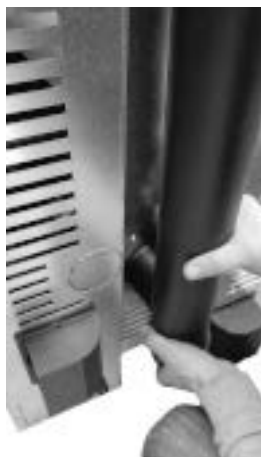
Fig. 72 - Acople el tubo d.80 mm
