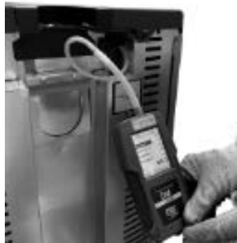
Fig. 106 - Conexión del presostato digital (Atena 3 Plus12/14 - Duke 12/14 At - Saba 12/14)
