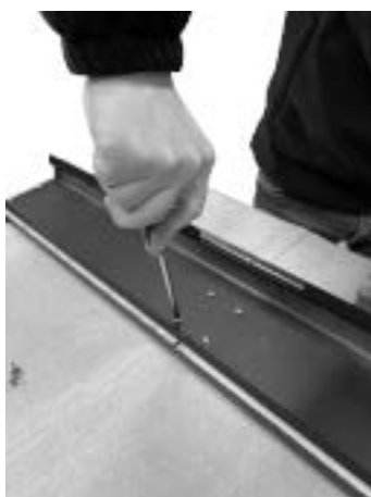
Fig. 33 - Montaje de las mayólicas
