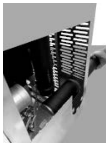
Fig. 94 - Das Kanalisationsrohr anschließen
