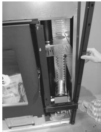
Fig. 52 - Insertar el montante
