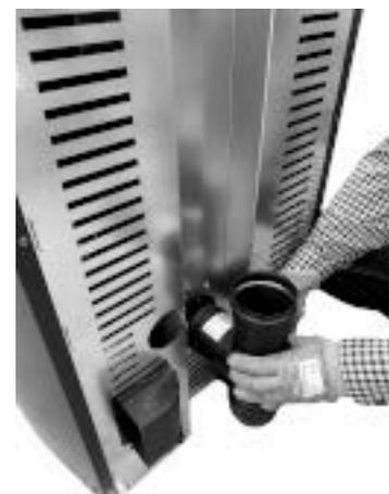
*Fig. 70 - T-Anschlussstück anschließen*
