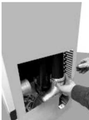
*Fig. 102 - Die Rohre anschließen*
