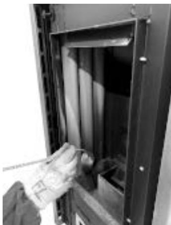
*Fig. 124 - Mit einer Rohrreinigungsbürste reinigen*
