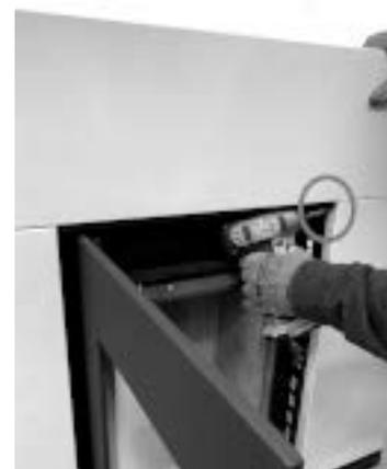
**Fig. 44 - Die obere Platte befestigen**
