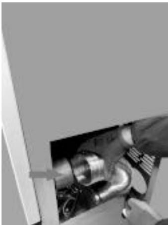
*Fig. 91 - Den Schlauch abziehen*
