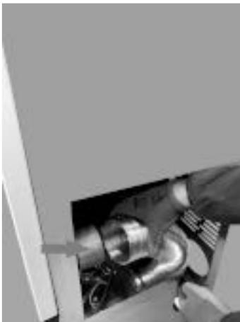
*Fig. 98 - Das Kanalisationsrohr einführen*
