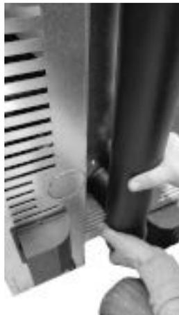
Fig. 75 - Rohr Durchm. 80 mm einstecken
