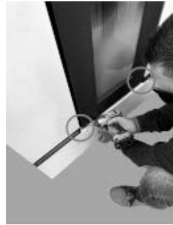
*Fig. 47 - Die untere Platte befestigen*
