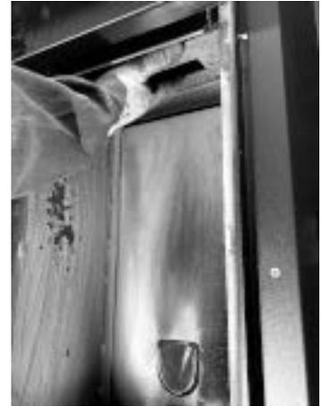
*Fig. 120 - Die Stirnseite des Feuerraums 1 entfernen*
