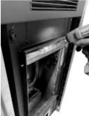
*Fig. 118 - Das Umlenblech entfernen*
