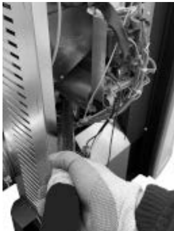
Fig. 130 - Room fan cleaning
