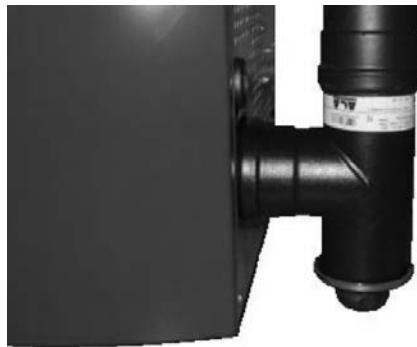
Fig. 117 - Fume conduit cleaning
