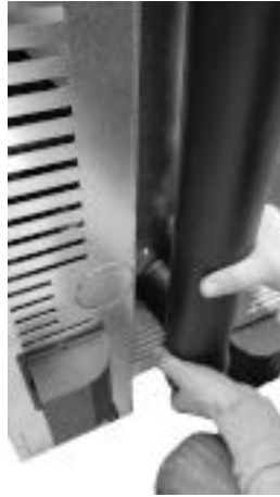
Fig. 75 - Insert pipe d.80 mm
