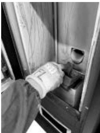
Fig. 112 - Remove the burning pot
