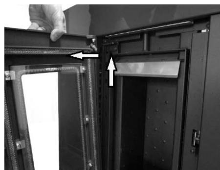
Fig. 20 - Door removal
