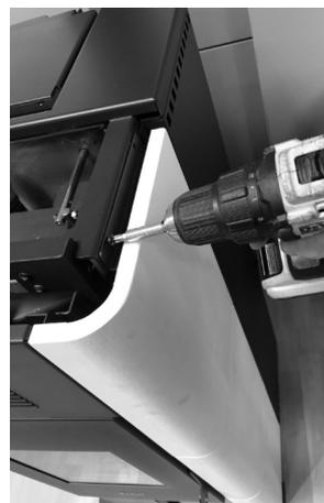
Fig. 31 - Fijación al panel
