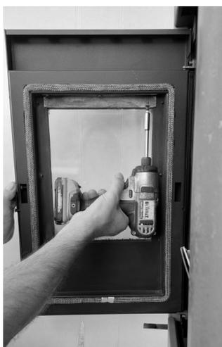
Fig. 53 - Desatornille los 3 tornillos
