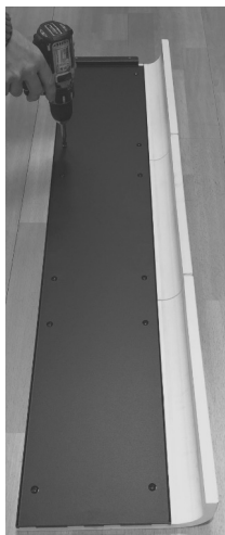
Fig. 26 - Verlegen der Majoliken
