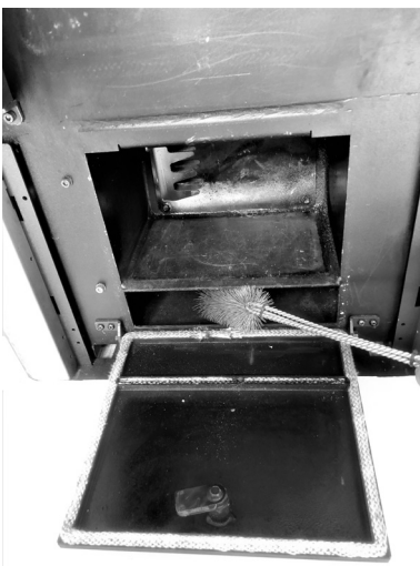
Fig. 58 - Mit einer Rohrreinigungsbürste reinigen
