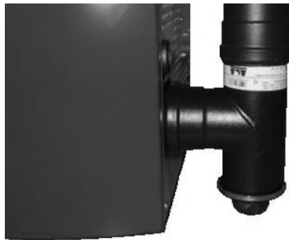
Fig. 53 - Reinigung des Rauchgaskanals
