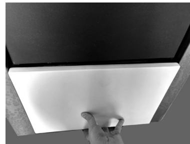
Fig. 25 - Bevestiging paneel
