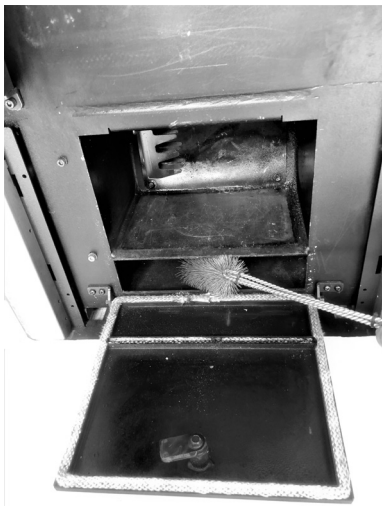
Fig. 58 - Reinig met pijpenwisser
