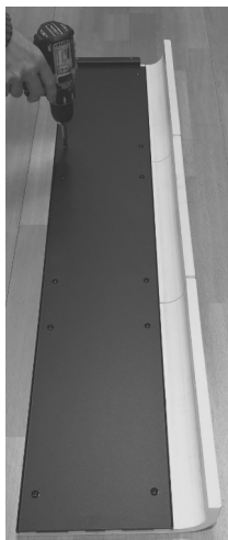
Fig. 26 - Montaggio maioliche
