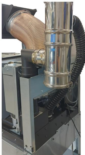
*Fig. 79 - Conexión del tubo concéntrico + aire comburente*
