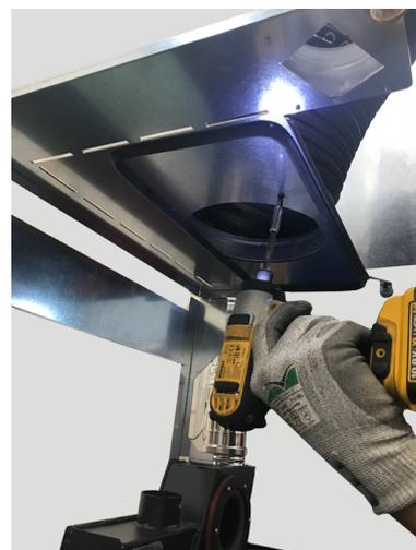
**Fig. 68 - Fijar el tubo flexible**
