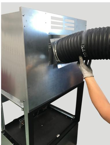
**Fig. 66 - Colocación del tubo flexible**
