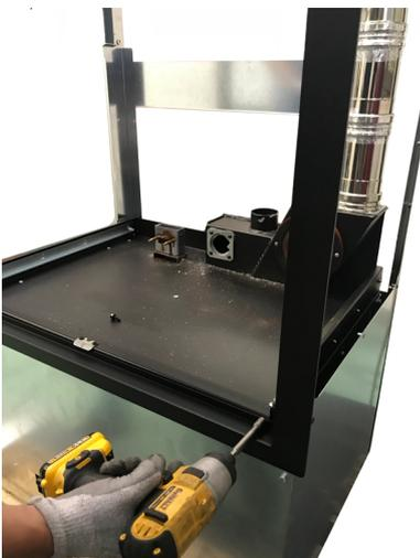
Fig. 75 - Fijación frontal
