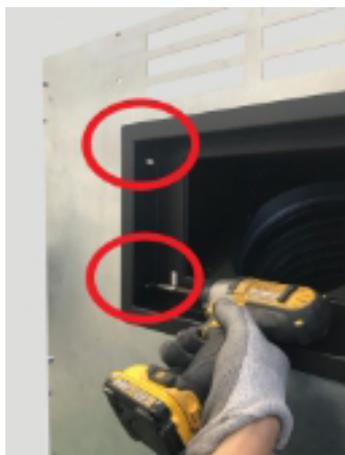
**Fig. 69 - Fijación del exterior de la trampilla**
