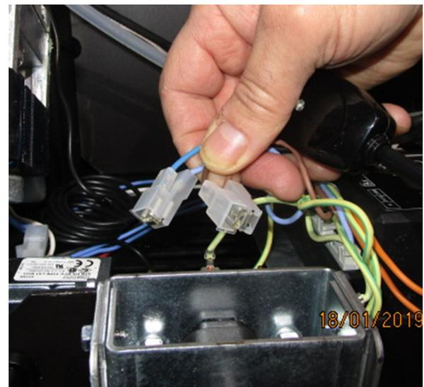
**Fig. 88 - Conexión de los terminales faston dobles**
