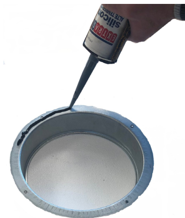
Fig. 68 - Silikon den Flansch
