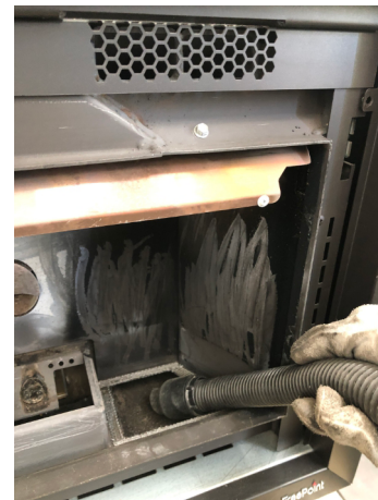
Fig. 105 - Die Asche absaugen
