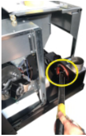
Fig. 115 - Reinigung des Rauchgaskanals
