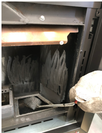
Fig. 104 - Mit einer Rohrreinigungsbürste reinigen
