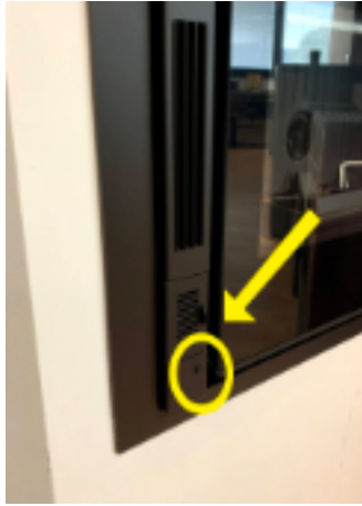
Fig. 29 - Thermostatsonde
