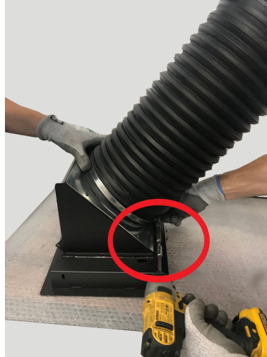
Fig. 65 - Schellen festziehen
