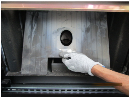
Fig. 112 - Entfernung der mittleren Wand aus Gusseisen
