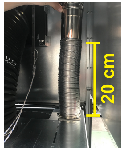
Fig. 49 - Aansluiting buigzame leiding (achteraanzicht van het inzetstuk)
