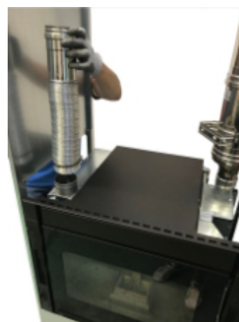
Fig. 63 - Plaatsing van het inbouwelement
