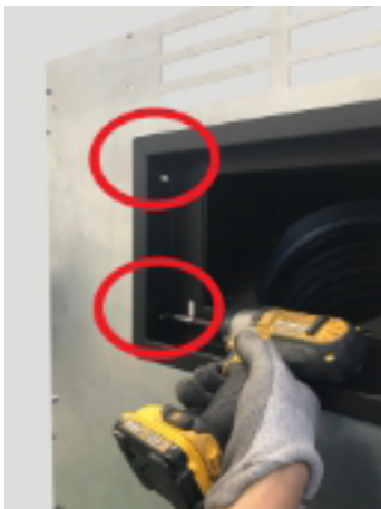
Fig. 70 - Externe bevestiging laadklep
