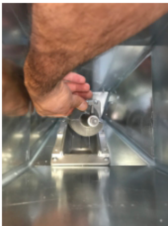
Fig. 94 - Verwijdering spiraal
